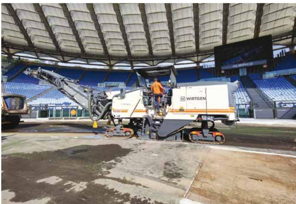
2. La fresa Wirtgen con sistema Trimble PavingControlSystem PCS900
